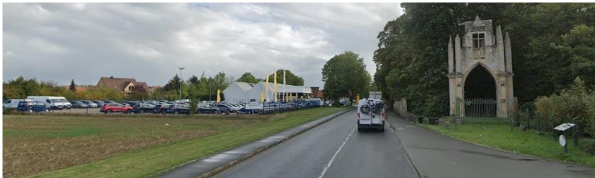
Le bâti proche de l'ancien portail se situe principalement dans le bourg de la commune de Sannerville, la route départementale 675 traçant la limite communale.
