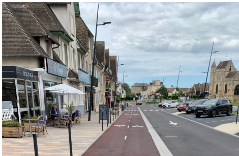
Piste cyclable le long de la RD613 à Cagny
