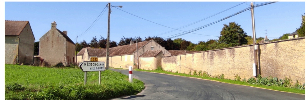
Murs en pierre
