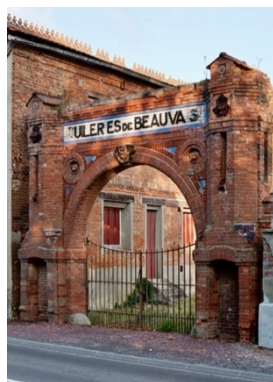
Ancienne tuilerie d'Argences
