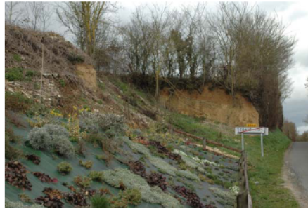
Vue générale sur le site 1 (© J. AVOINE)
