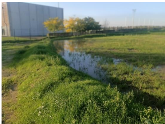
Photographie d'une zone de gestion des eaux pluviales organisée en amont d'un merlon colonisée par des plantes adaptées aux milieux humides (conception et réalisation AtelierLD)
