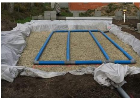
Exemple de structure réservoir en cours de construction
