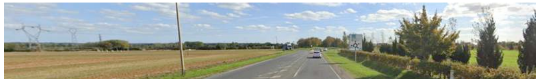
Vue sur la sucrerie (avant démolition) depuis l'est
