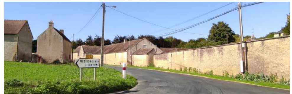
Murs en pierre
